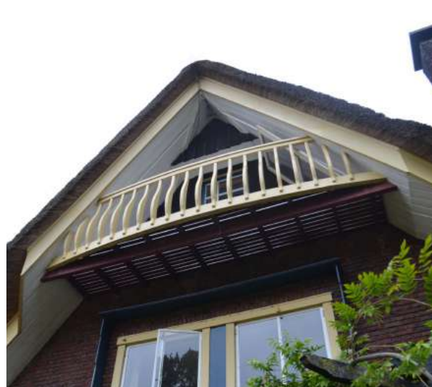
Het balkon van de nokkamer in de zuidgevel. Dit balkon staat niet op de bouwtekeningen aangegeven.
