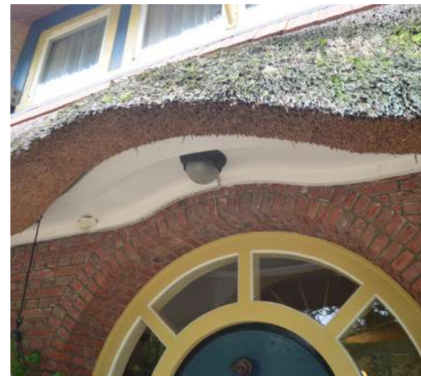
Boven de voordeur is het rieten dak een stukje 'opgelicht en uitgebogen' zodat een afdakje is gevormd.
