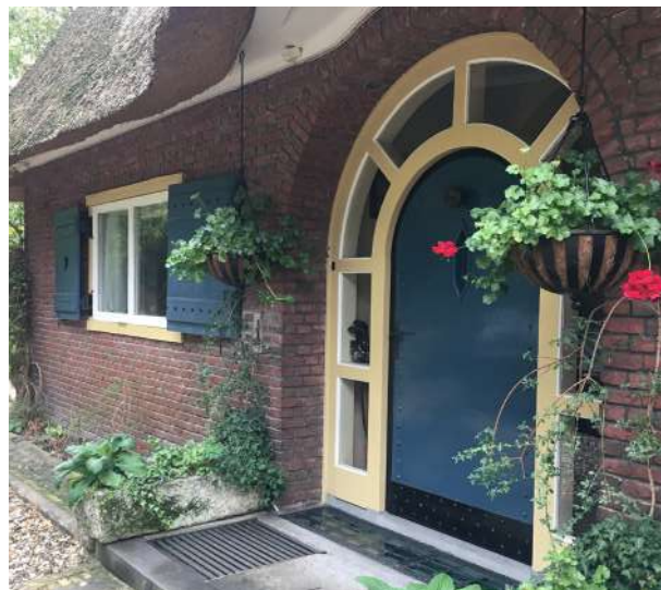
De hoofdentree met metalen voordeur, een glazen lichtstrook in de stoep voor daglicht in de kelder en kunstlicht op de voordeur.
