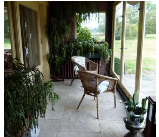
De vloer van de serre is van Bentheimer tegels. De glasramen kunnen uit de kozijnen gehaald worden tijdens de zomer.
