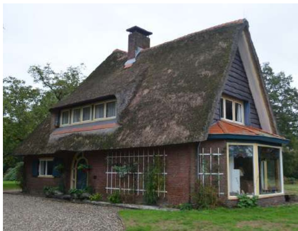
Zicht op de voorgevel (noordoost) van het huis met rechts de later aangebouwde erker.
