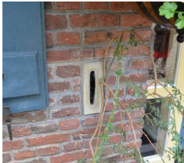
Aan de andere zijde van de voordeur is een natuurstenen brievenbus ingemetseld.
