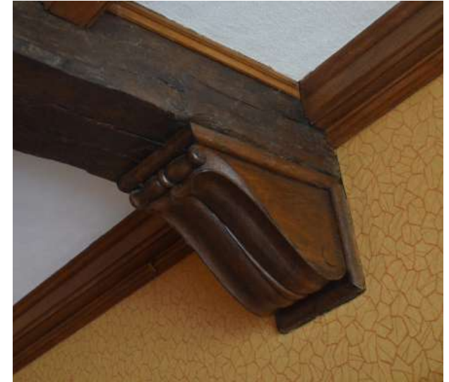
Het balkenplafond wordt ondersteund door als bladeren gevormde consoles.
