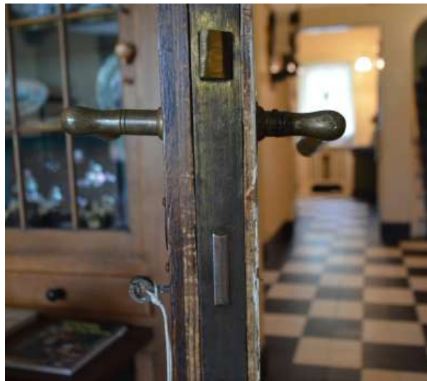
Doorkijkje langs de originele deur vanuit de zitkamer naar de hal met de wastafel in de verte.
