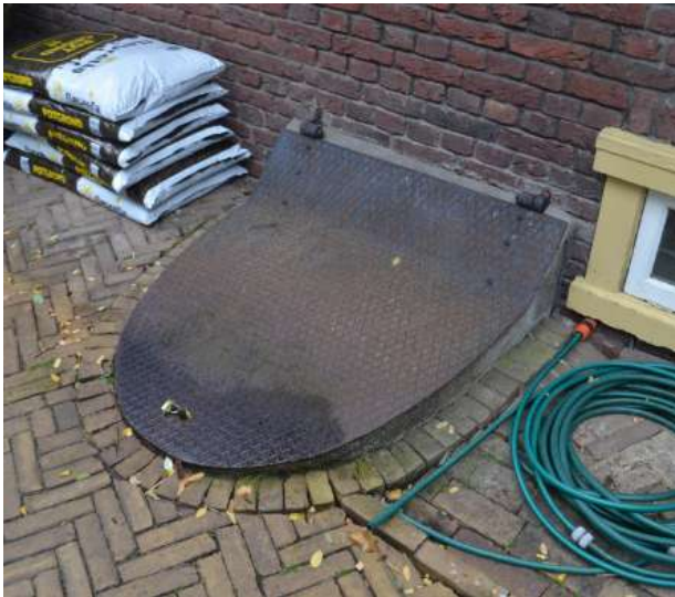
Kolenluik naar de kelder met metalen afdekplaat tegen de oostelijke zijgevel.
