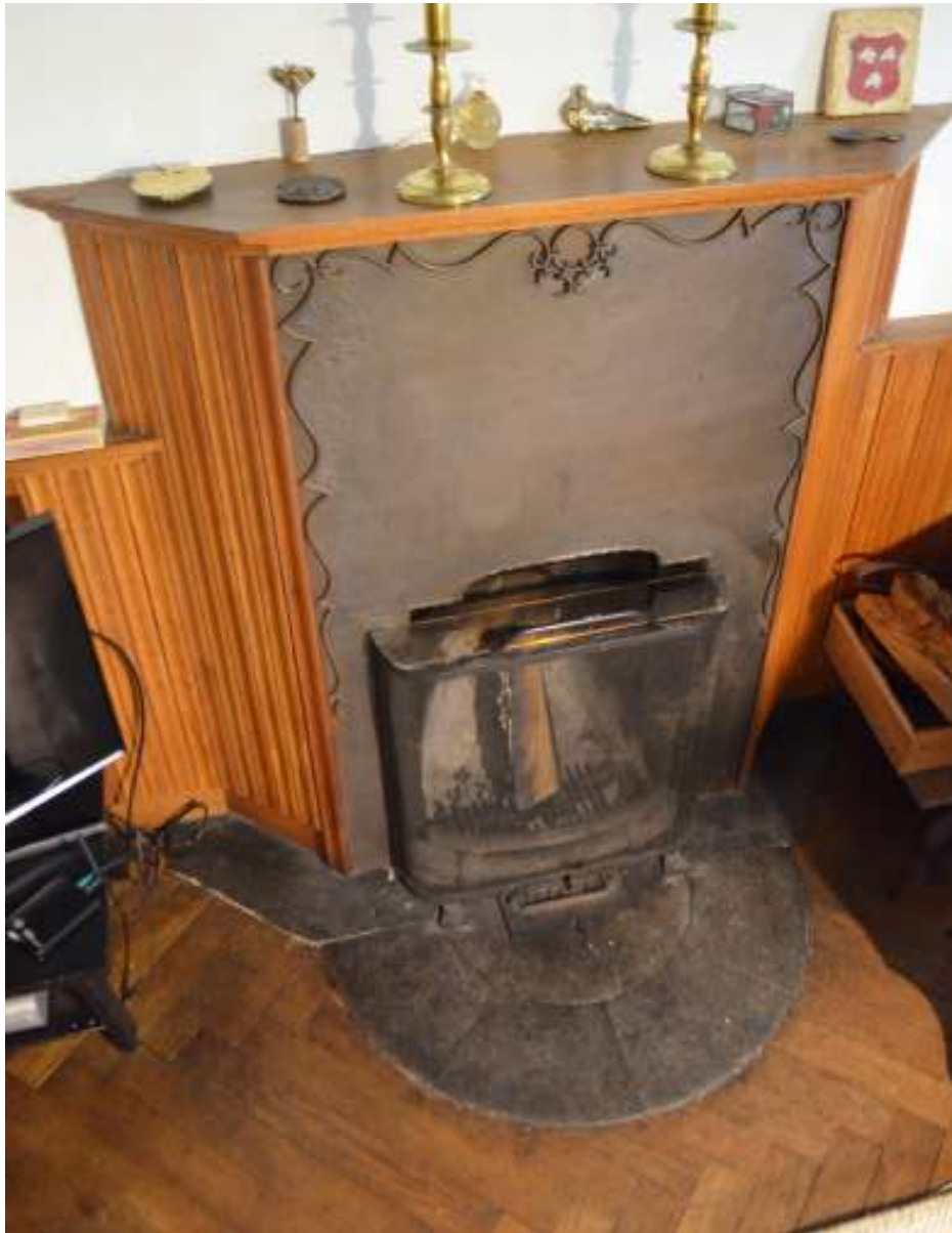
De schouw in de eetkamer met een asla die uitkomt in de kelder.
